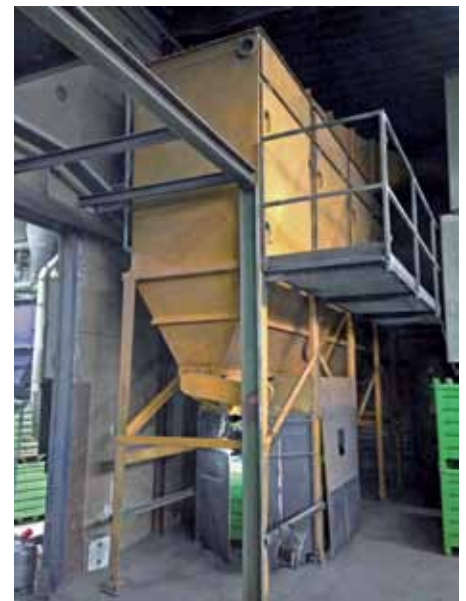
02 Filteranlage im Einsatz bei Cablo
