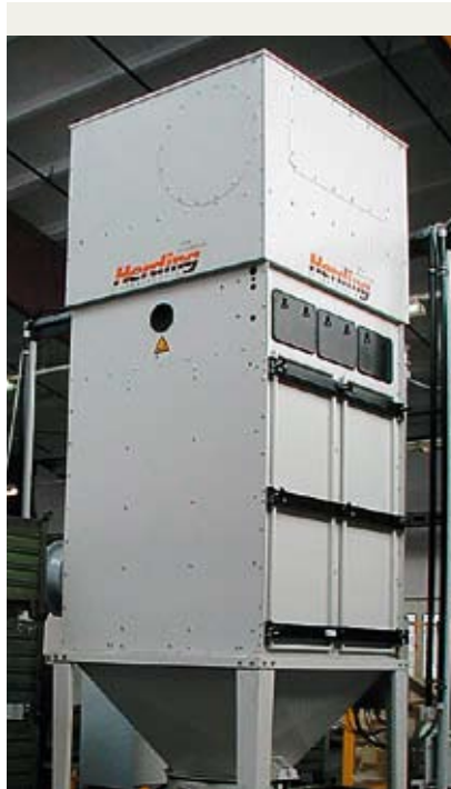
Filtereinheit zur Abscheidung von Nasslack bei der Felgenlackierung
